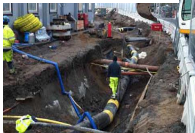
Figura 6 - Construção de tubulações subterrâneas .
