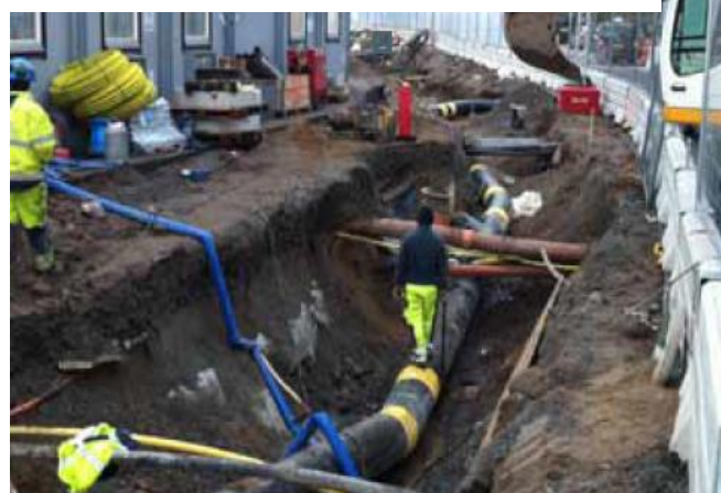
Figura 6 - Construção de tubulações subterrâneas .
