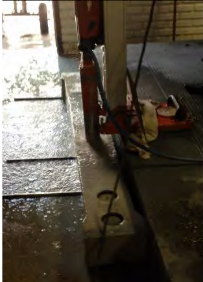
Figura 5: Extração de testemunhos dos pilares
