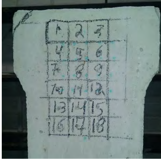
Figura 3: Marcação dos pontos de medição na superfície do pilar (PAIGEL et al., 2015)
