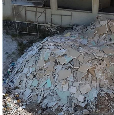
Figura 6: Resíduos de drywall
