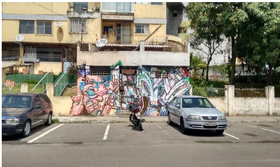
Figura 30. Obra de embelezamento – Atlântica Ville (Vitória – ES)
