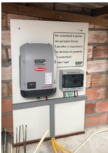
Figura 6 – Exemplo de um módulo inversor de frequência Fonte: Autoria própria.
