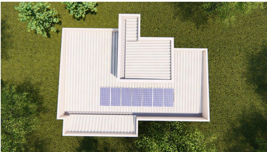
Figura 8 – Vista superior da cobertura. Fonte: Autoria própria.
