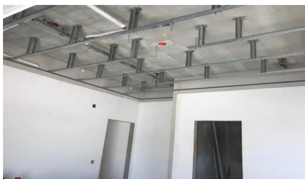
Figura 04 –Armação para colocação de PGA
