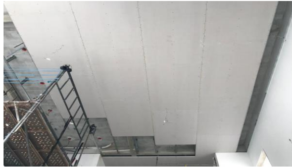
Figura 05 – Instalação de PGA
