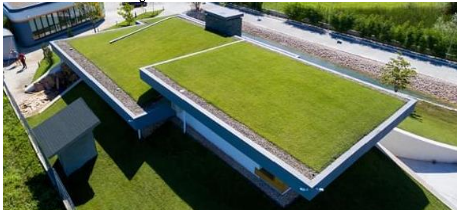
Figura 2 – Telhado verde extensivo
