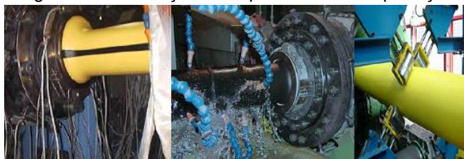
Figura 12: Fabricação da capa externa e de proteção.
