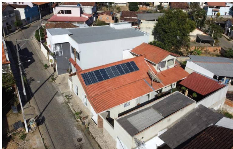
Figura 3 – Módulos solares em uma residência de Nova Venécia
