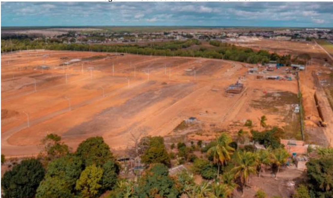
Imagem 1 – Obra do loteamento Reserva Jardim
