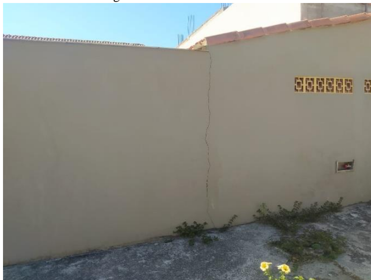
Imagem 2: Fissura em alvenaria de fachada
