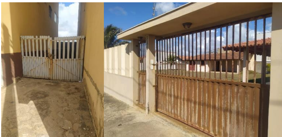
Imagem 6: Portão da fachada em estado de corrosão
