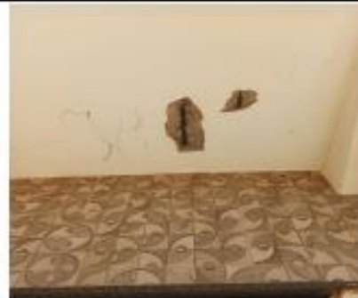
Viga em estado corrosivo o ocasionando deslocamento
