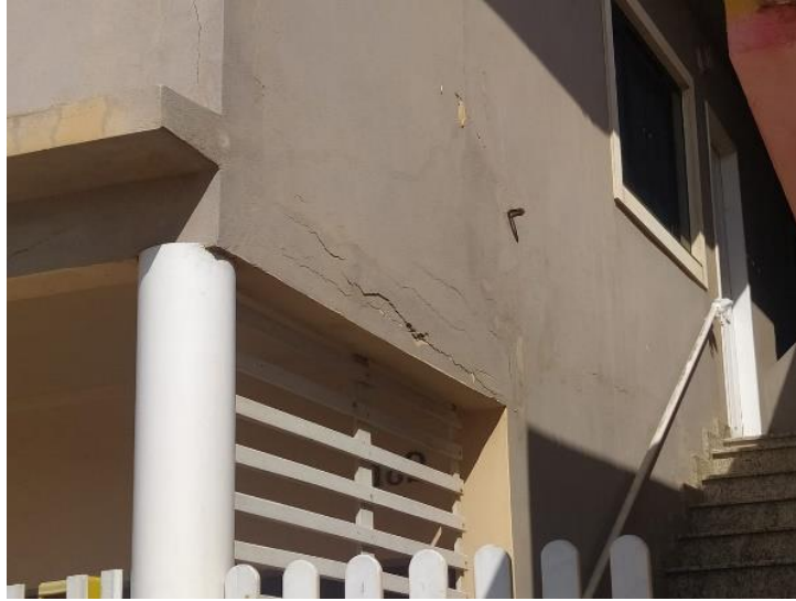
Imagem 2: Fissura em alvenaria de fachada
