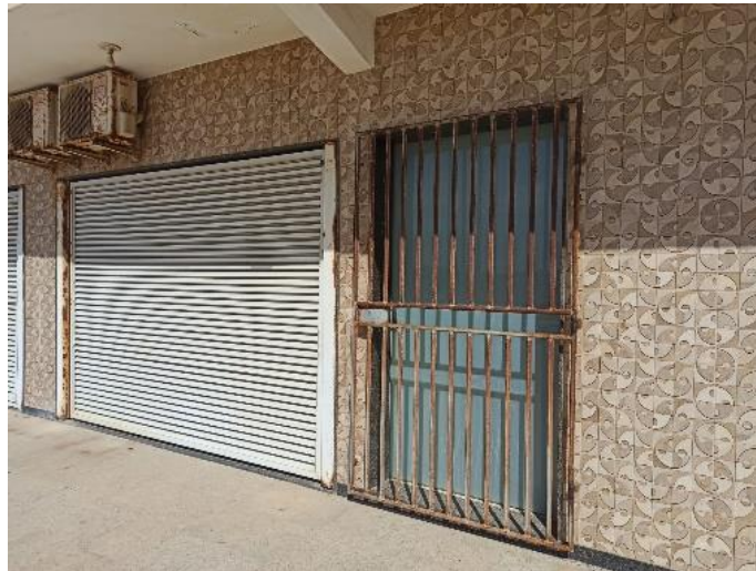
Imagem 6: Portão da fachada em estado de corrosão
